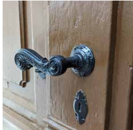
Nun sind sie fertig: Die Türen der St.-Lucas-Kirche erstrahlen wieder für viele Jahre
