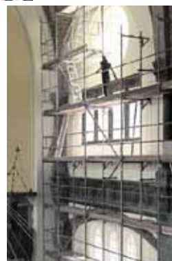
GROSSER AUFWAND: Elke Maier klettert aufs Gerüst, befestigt die Fäden in 14 Metern Höhe, klettert wieder herunter, verspannt die Fäden – und dann wieder von vorn. 22.000 Fäden wurden so verspannt. Foto: Gernar
